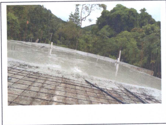
CONCRETAGEM DA LAJE DO 2º PAVIMENTO
