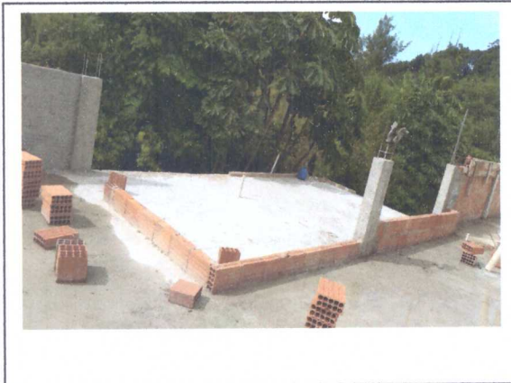
ASSENTAMENTO DE TIJOLO, (PLATIBANDA)
