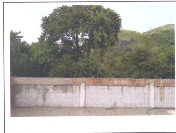
CONCRETAGEM DA VIGA DE TRAVAMENTO DA PLATIBANDA
