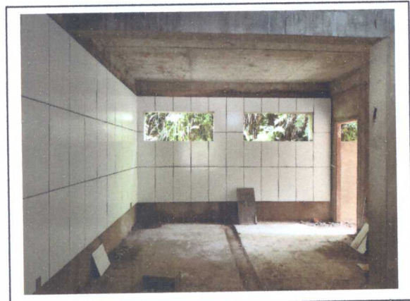
ASSENTAMENTO DE REVESTIMENTO
