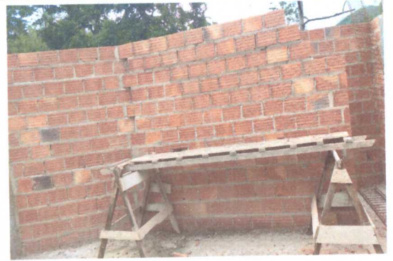
ASSENTAMENTO DE TIJOLO CERÂMICO
