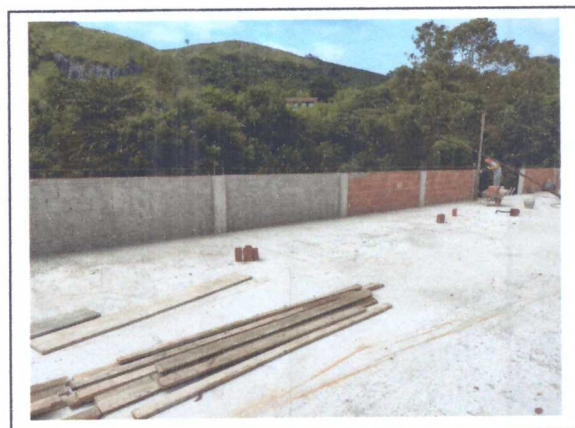
EXECUÇÃO DE CHAPISCO, (PLATIBANDA)
