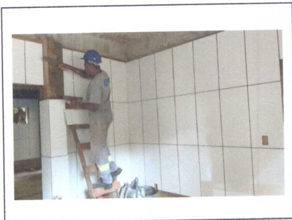
ASSENTAMENTO DE REVESTIMENTO
