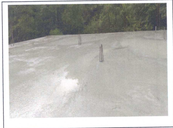
CONCRETAGEM DA LAJE DO 2º PAVIMENTO
