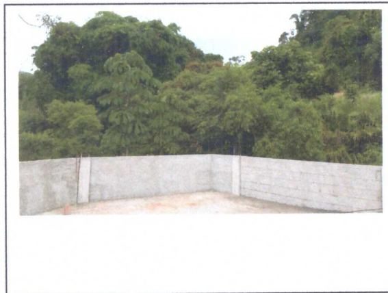
EXECUÇÃO DE CHAPISCO, (PLATIBANDA)
