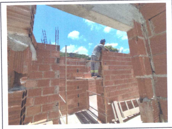
ASSENTAMENTO DE TIJOLO CERÂMICO
