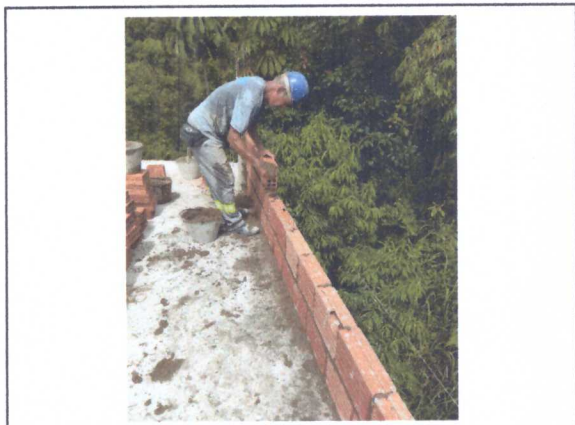
ASSENTAMENTO DE TIJOLO, (PLATIBANDA)
