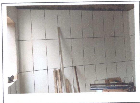
ASSENTAMENTO DE REVESTIMENTO
