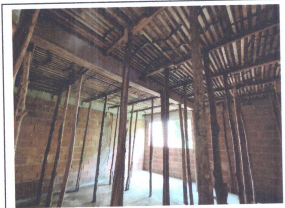
ESCORAMENTO DA LAJE D 2º PAVIMENTO
