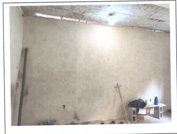
EXECUÇÃO DE REBOCO
