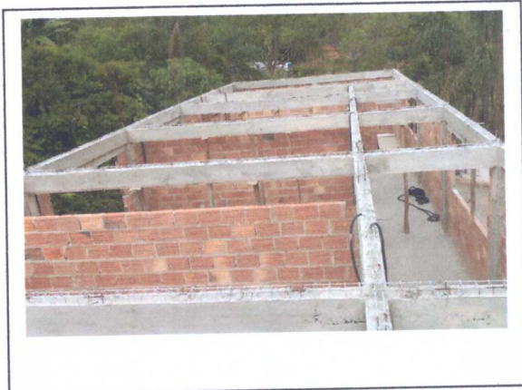
VIGA AÉREA CONCRETADA, (CINTAMENTO)
