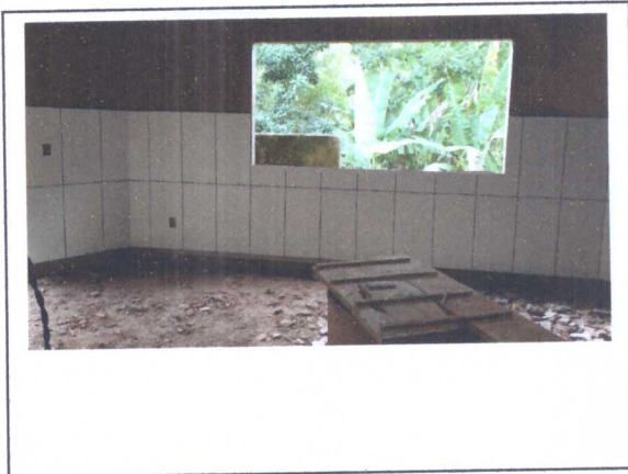
ASSENTAMENTO DE REVESTIMENTO
