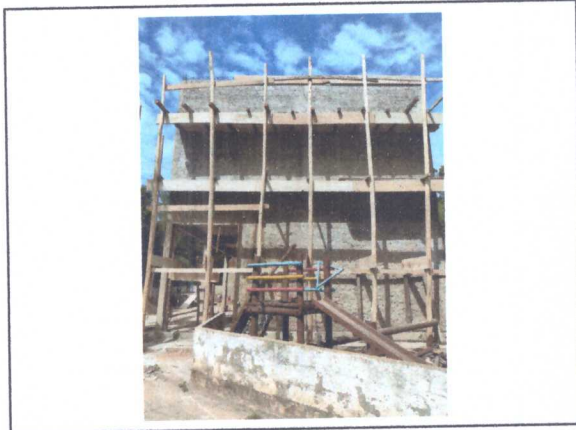
EXECUÇÃO DE CHAPISCO
